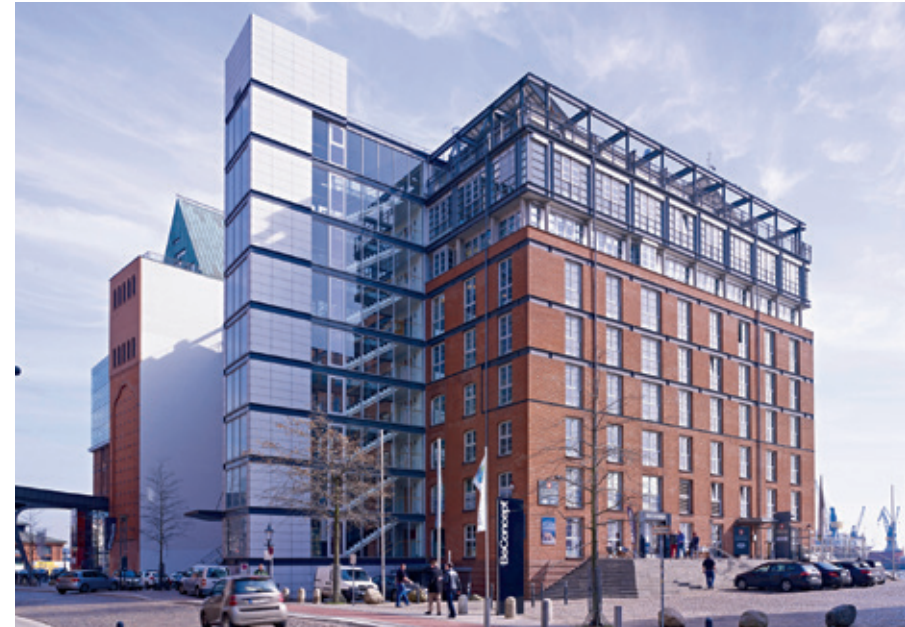
Das „GINN Hotel Hamburg“ mit über 132 Zimmern wird im Frühsommer 2017 auf vier ehemaligen Büroetagen eröffnet. In dem direkt an der Elbe gelegenen Speichergebäude befinden sich zudem Einzelhandels- und Büroflächen sowie ein Restaurant.
